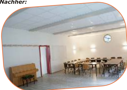
Neuer Boden, neue Decke - modernes Design. Der neu renovierte Saal ist freundlich und hell.
