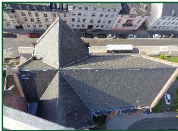
Das Dach unserer Oranier-Gedächtnis-Kirche
